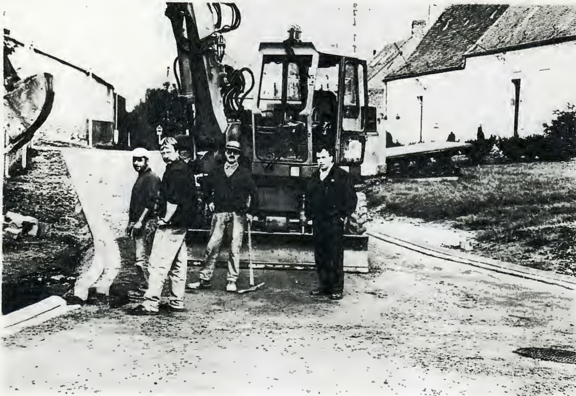
Les rues d'Amerval et de l'Eglise ont été assainies puis remises en état.
