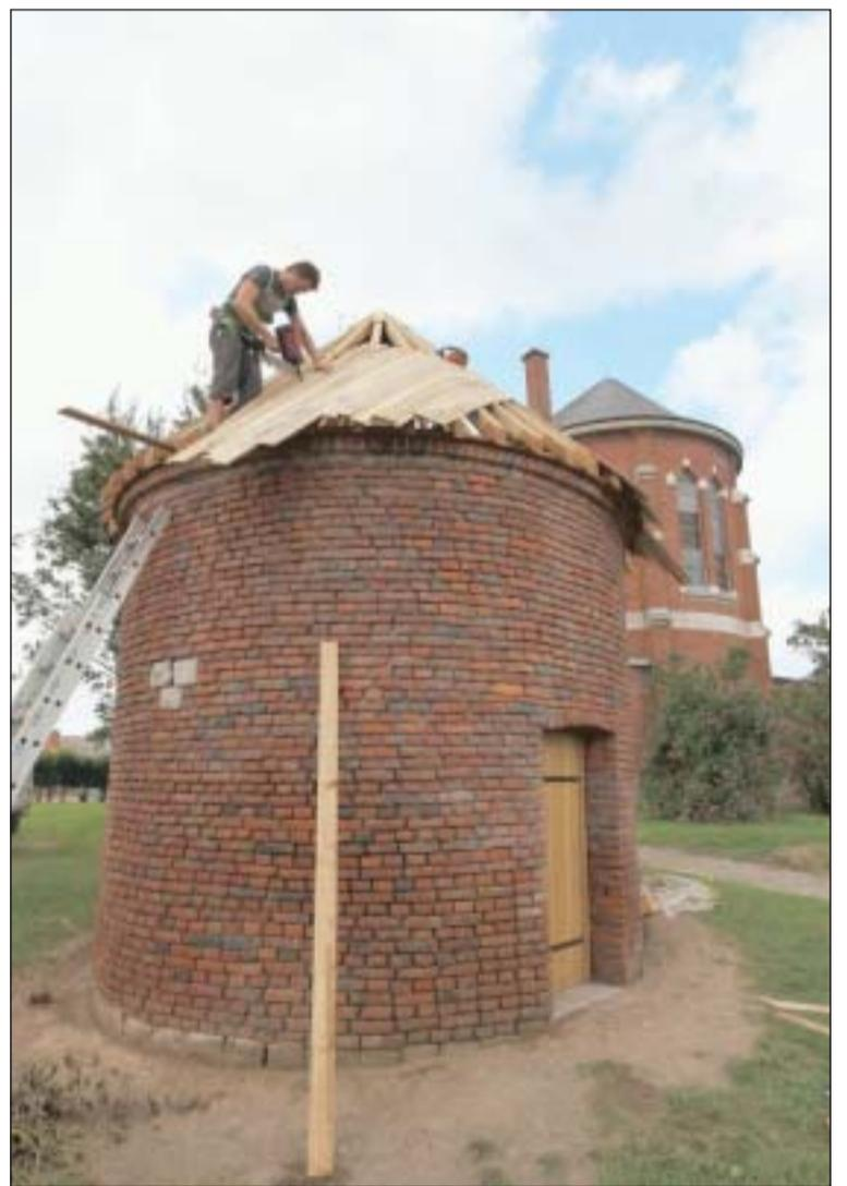
Juché sur la charpente, Gaspard Delsart s'applique à fixer les voliges sur lesquelles il viendra bientôt fixer les ardoises.
