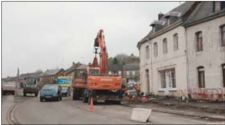
Les Maroillais ont subi plusieurs mois de travaux. La municipalité tient à expliquer les prochaines étapes des chantiers.
